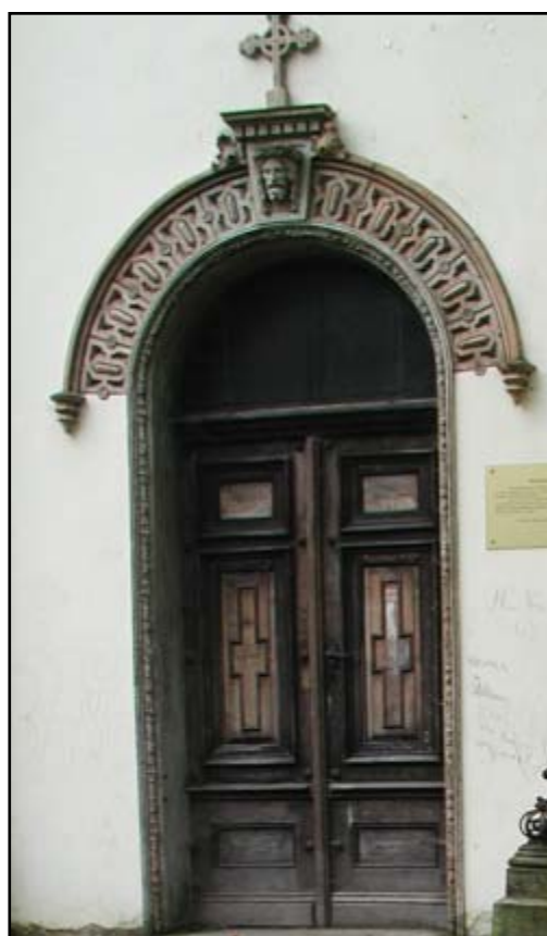
▼ Česká Kamenice/00150, Preidlova hrobka, fotodokumentace, pohled od severu, detail dveří
