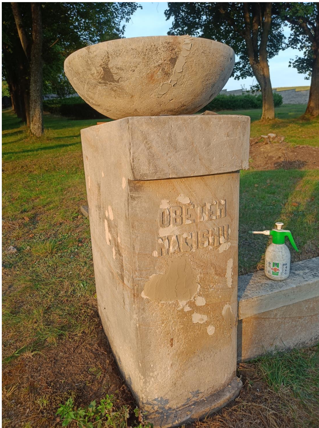
Postup práce – stav po vyčištění, tmelení a spárování
