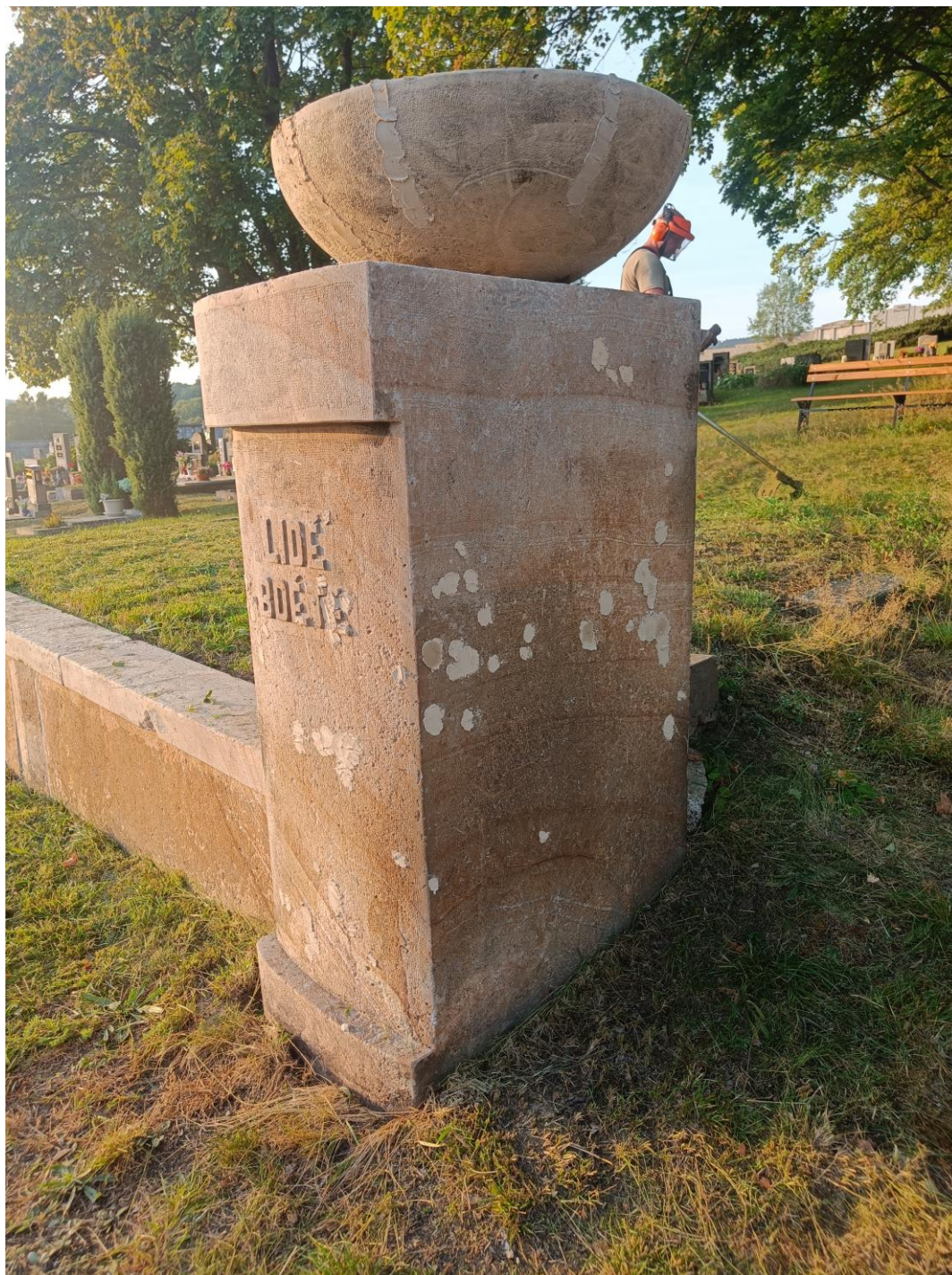
Levý pilíř, postup práce, tmelení poškozených míst
