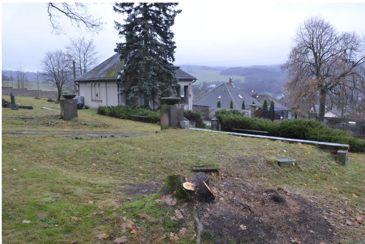
Celkový pohled na zídky s mísami na věčný oheň – stav před restaurováním
